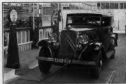
Le Contrôle du Pincement des Roues avant.
